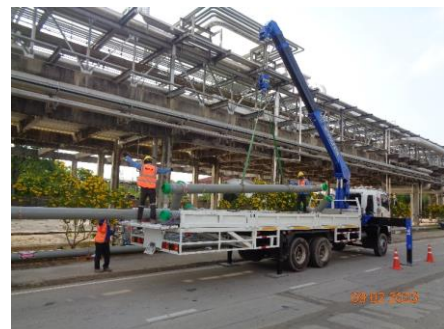
ภาพที่ 2-31 การผูกมัดท่อและอุปกรณ์ขณะทำการขนย้าย ด้วยรถบรรทุก
