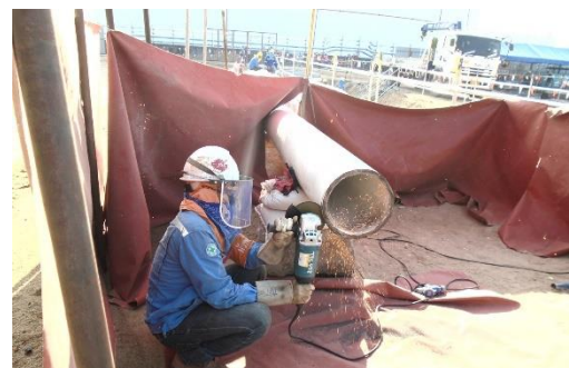
ภาพที่ 2-43 โครงสร้างหลัก (Pipe camp) ไม่กระดานปูพื้น ผ้ากันไฟ สำหรับการป้องกันสะเก็ดไฟและความร้อนจากงานเชื่อม
