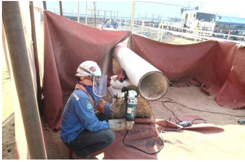
ภาพที่ 2-34 อุปกรณ์ป้องกันอันตรายส่วนบุคคล (PPE) สำหรับงานเชื่อมต่อท่อ และตรวจสอบรอยเชื่อม
