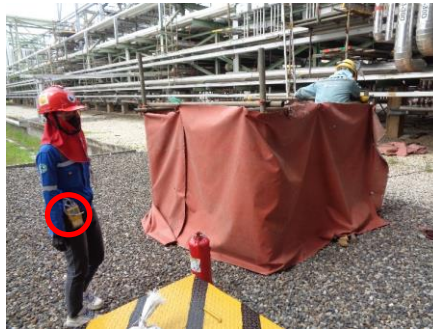
ภาพที่ 2-35 เครื่องมือตรวจจับก๊าซในพื้นที่ปฏิบัติงาน (Gas Detector)
