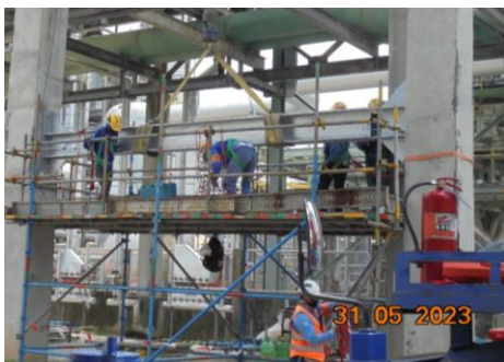
ภาพที่ 2-41 พนักงานสวมใส่และใช้อุปกรณ์ป้องกันการตก
