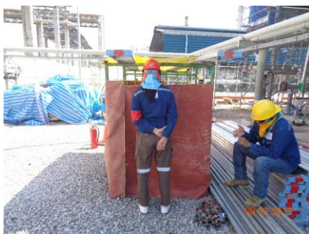
ภาพที่ 2-43 โครงสร้างหลัก (Pipe camp) ไม่กระดานปูพื้น ผ้ากันไฟ สำหรับการป้องกันสะเก็ดไฟและความร้อนจากงานเชื่อม
