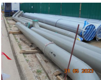
ภาพที่ 2-32 วัสดุที่ใช้ในการวางท่อบริเวณพื้นที่เก็บท่อ เพื่อป้องกันการพังทลาย อาทิ ลิ่มไม้
