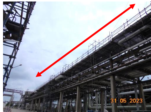
ภาพที่ 2-40 การติดตั้งอุปกรณ์กันตก เช่น ราวกันตก แผ่นกันตก นั่งร้าน ตาข่าย
