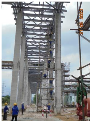
ภาพที่ 2-39 การติดตั้งนั่งร้าน
